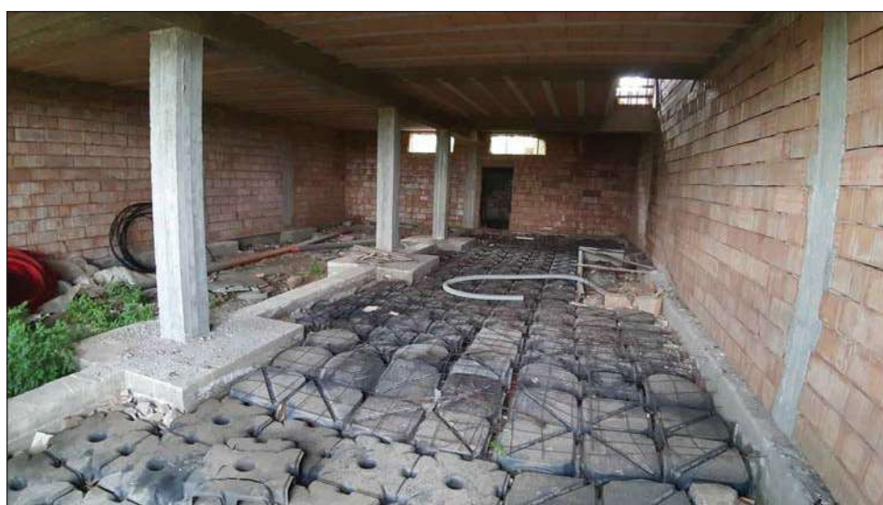
foto 20 - vista del piano seminterrato sub 2.
