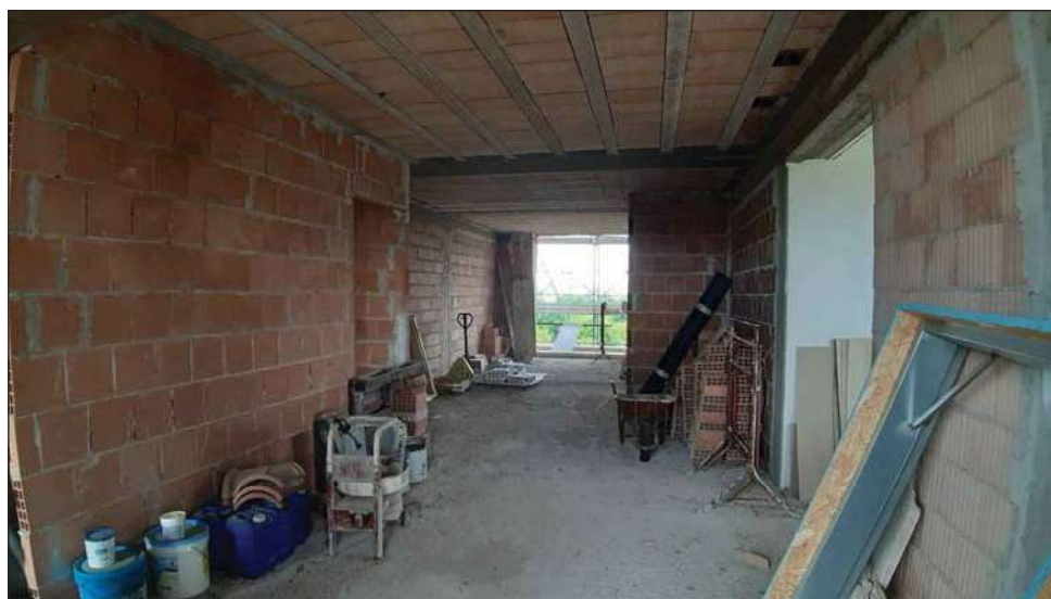
foto 21 - vista del piano terra del sub 2.
