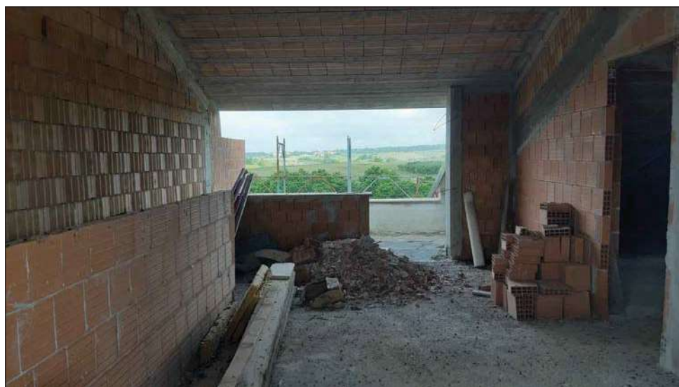
foto 23 - vista del piano 1° del sub 2.
