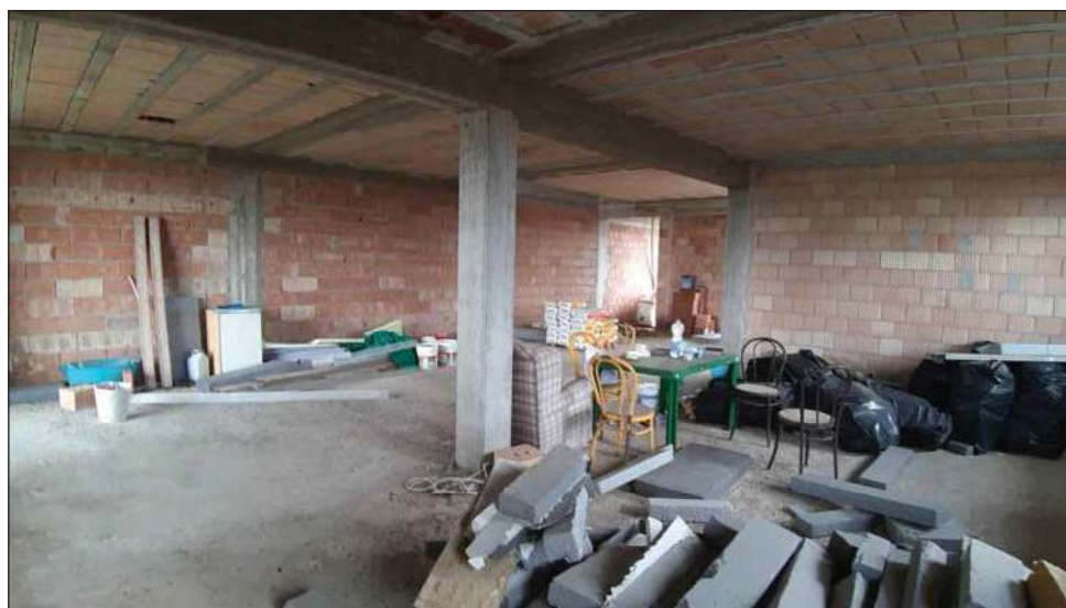
foto 25 - vista del piano terra del sub I.
