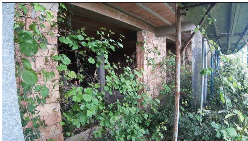
foto 19 - vista dell'ingresso al piano seminterrato sub 2.
